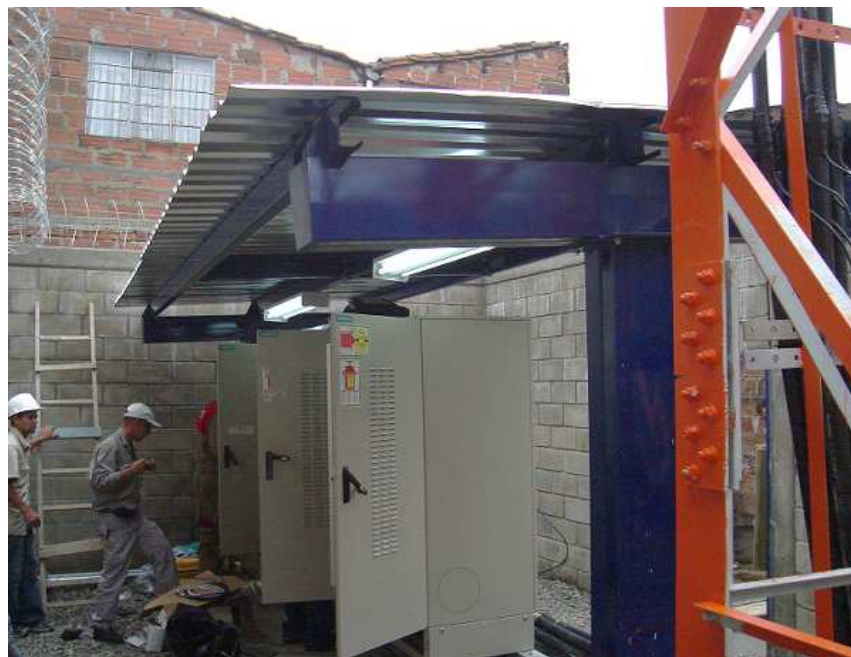
Montajes de equipos y estructuras metalmecánicas
