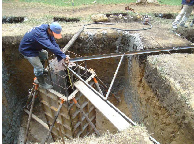
Diseño y construcción de cimentaciones
